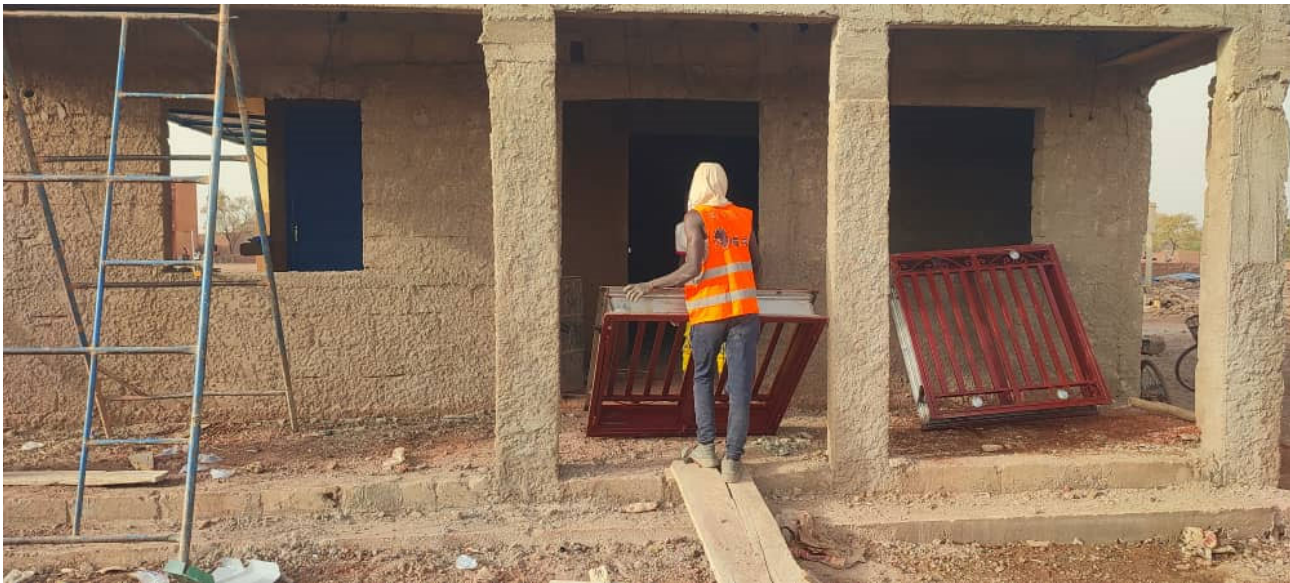
Rohbau der Bäckerei
