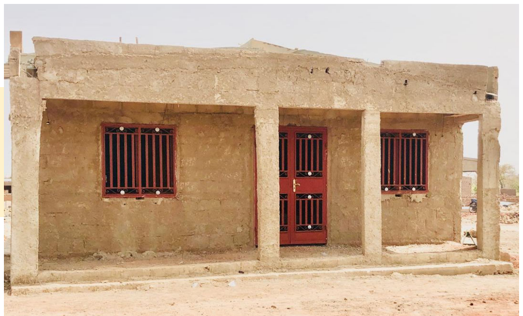
Rohbau der Bäckerei
